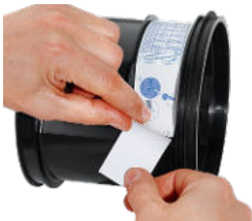
Rys. 6: Zakrywanie szczeliny
